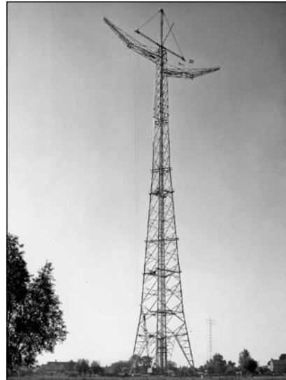
Mast Lekkerkerk, de hoogste van Nederland
