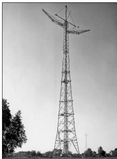
Mast Lekkerkerk, de hoogste van Nederland
